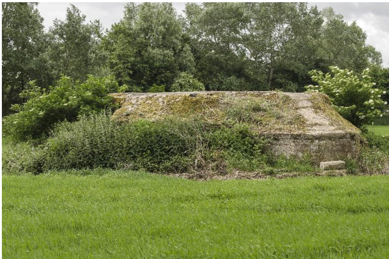
Vue latérale vers le sud-ouest
