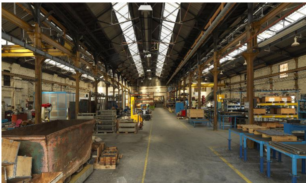
Vue d'ensemble intérieure de l'atelier de mécanique.
