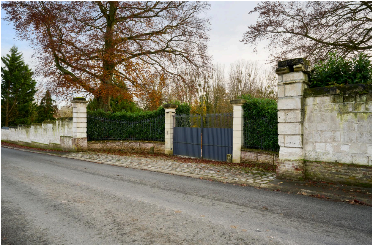
Portail d'entrée du château, depuis le nord.
