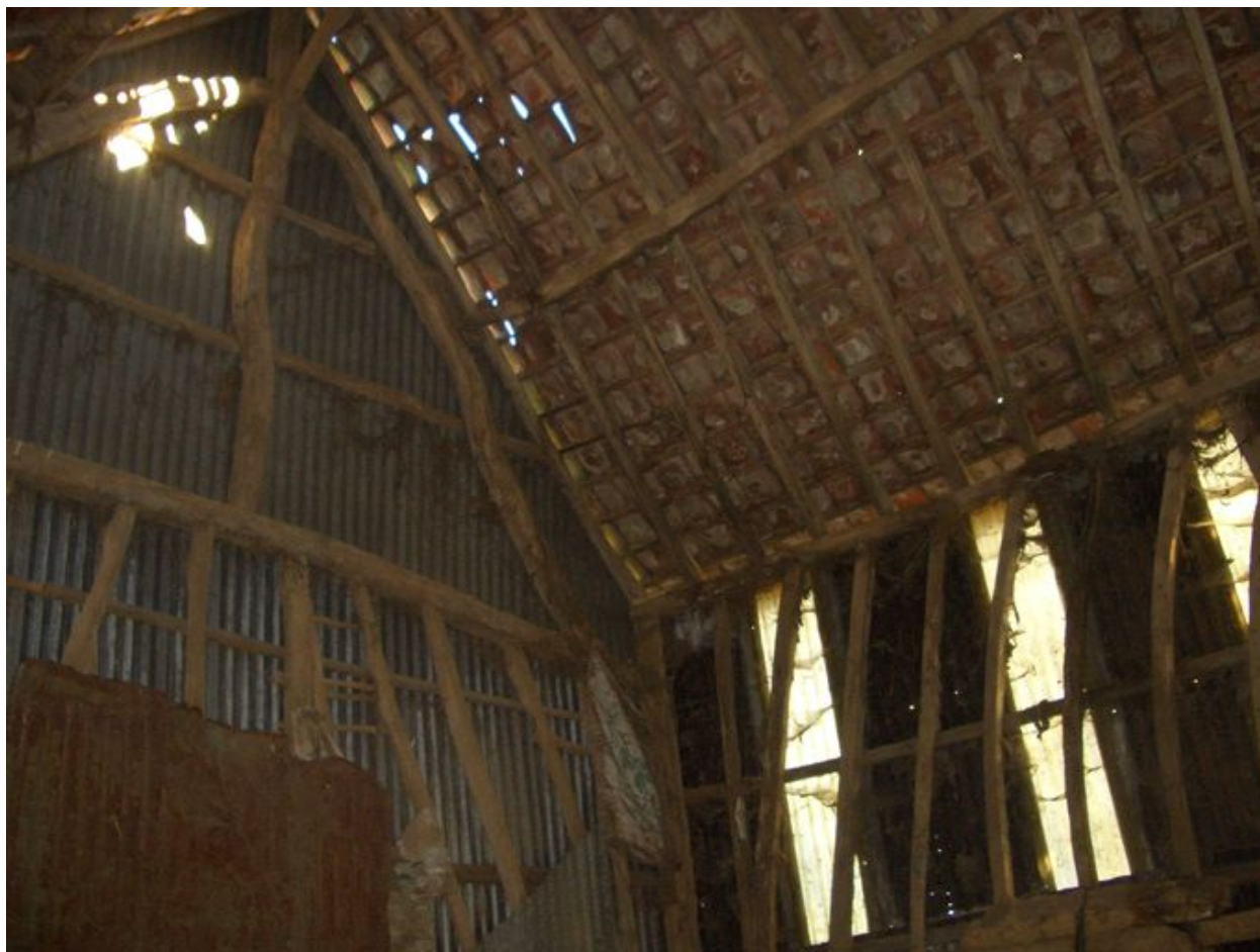
Vue intérieure de la grange.
