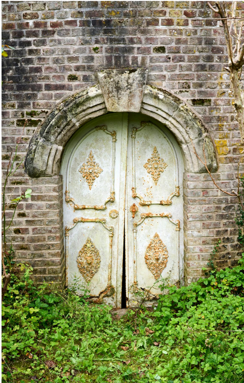
Porte d'entrée des caves installées sous la terrasse, depuis le nord.
