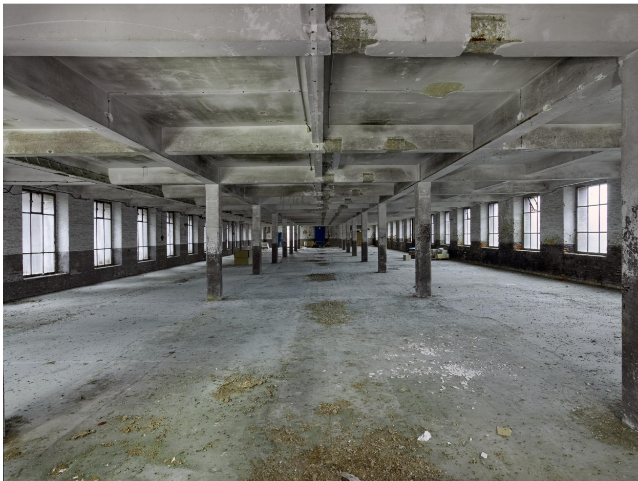
Vue intérieure longitudinale du premier étage en béton de l'atelier de fabrication (bâtiment A).
