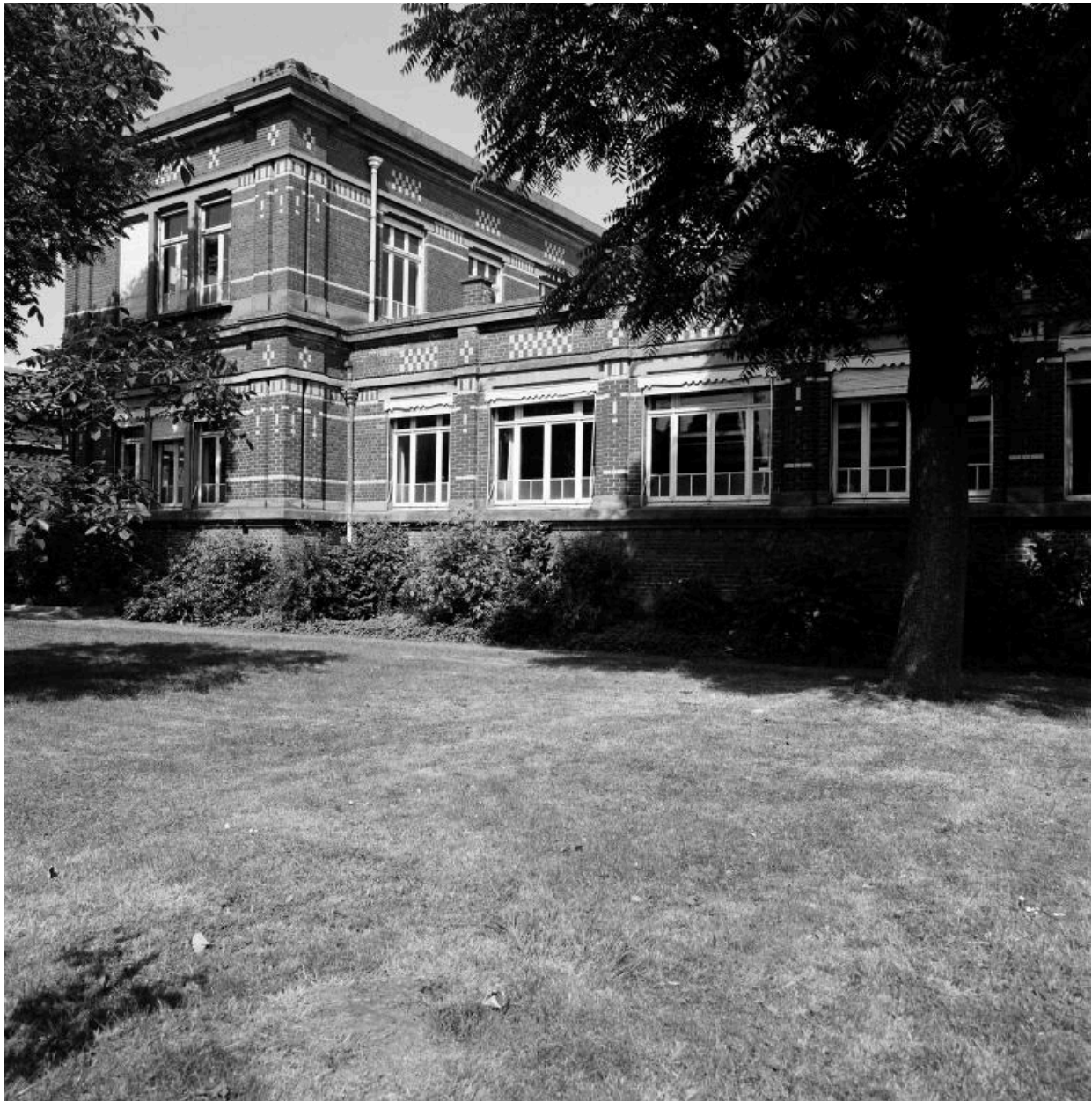
Bureaux. Aile ouest vue depuis la cour.
