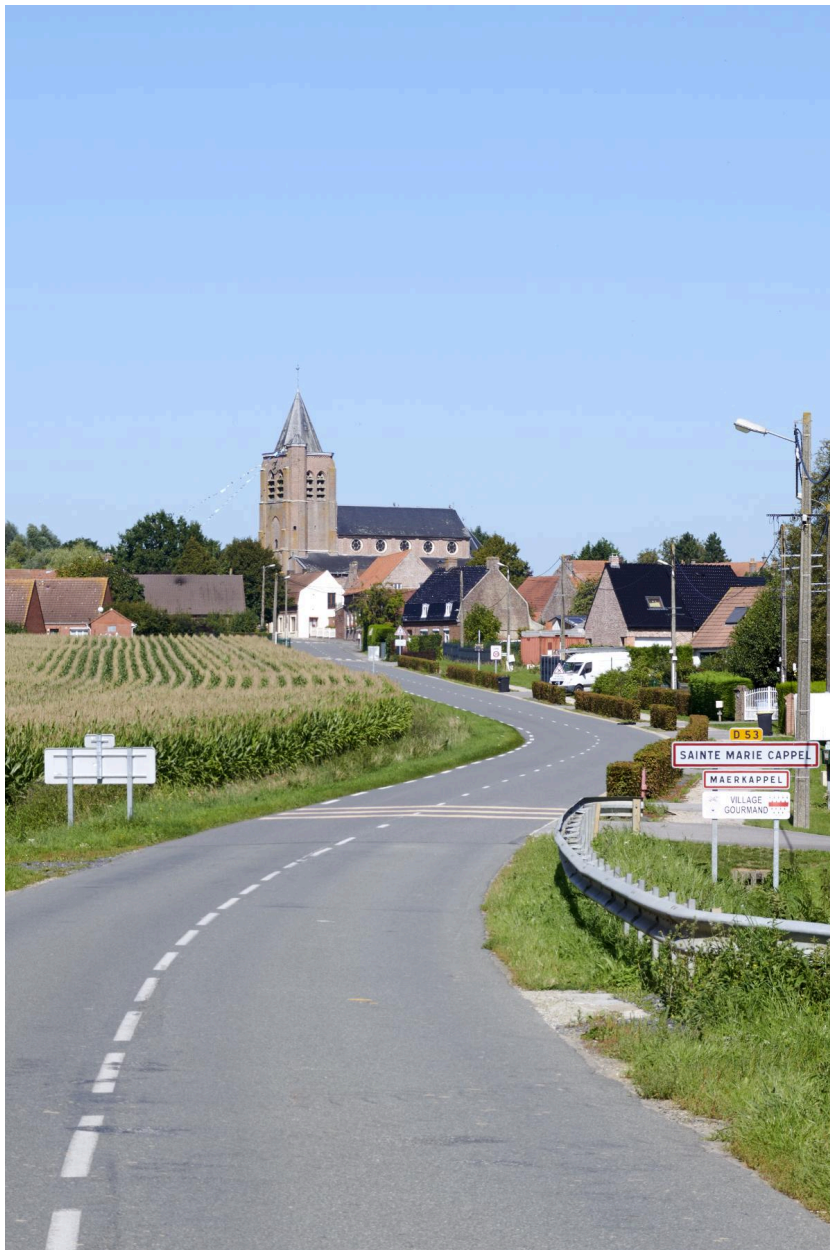
Église depuis le sud du village.
