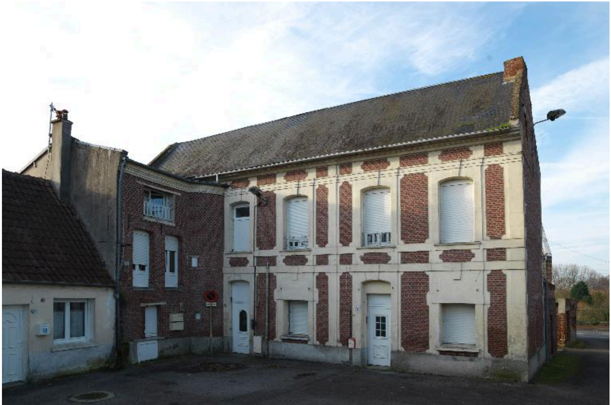
Vue générale, depuis l'est.
