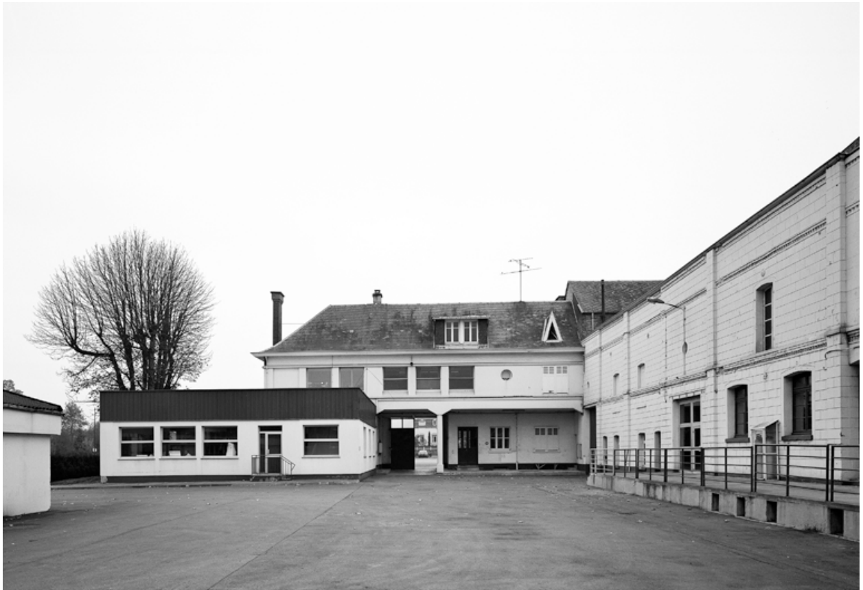
Elévation sur cour des bureaux.
