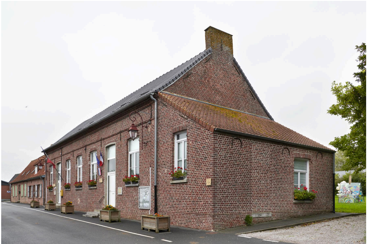
Vue de la façade sur rue, depuis le sud-est.
