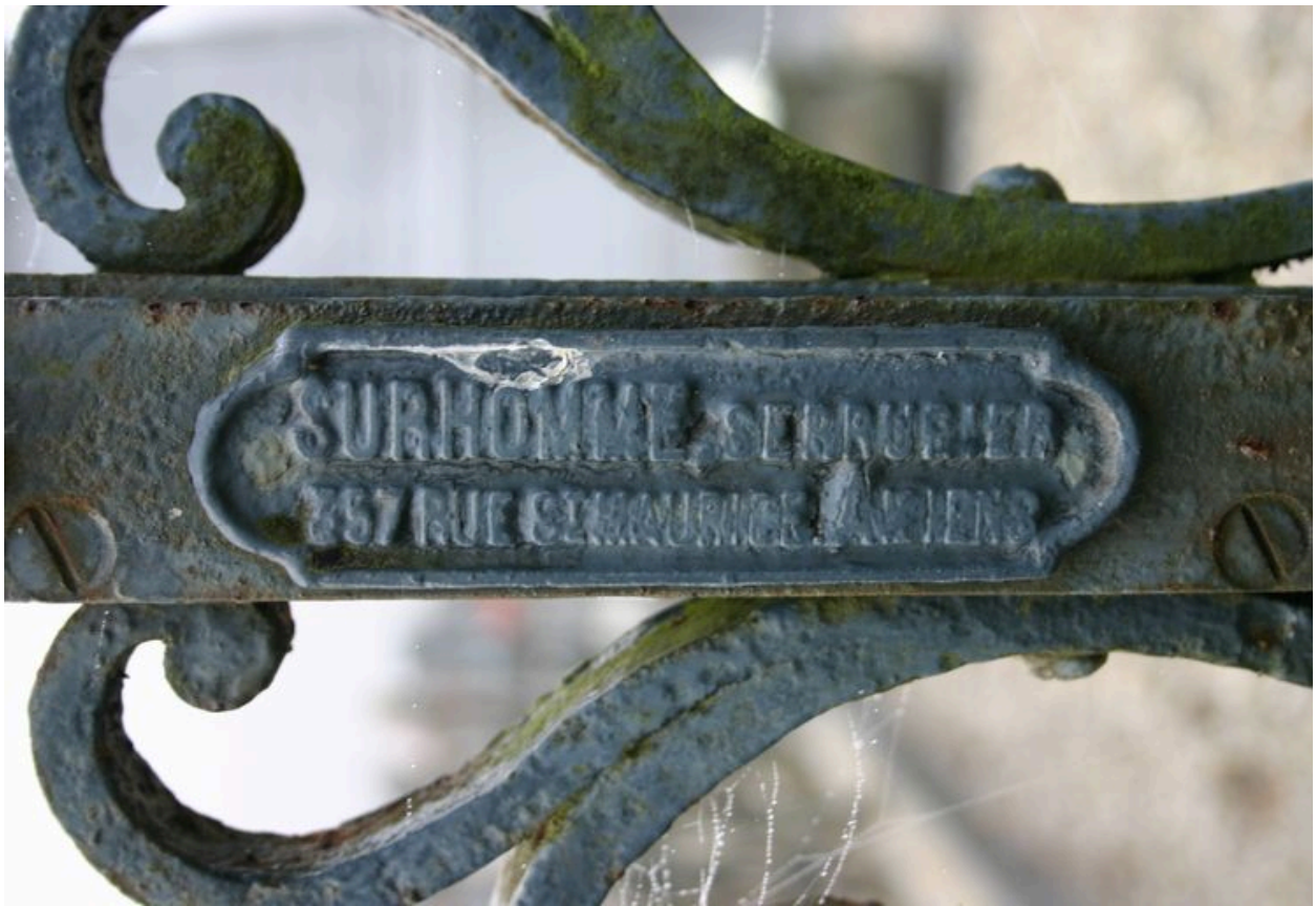
Portillon de clôture : signature du serrurier Surhomme.
