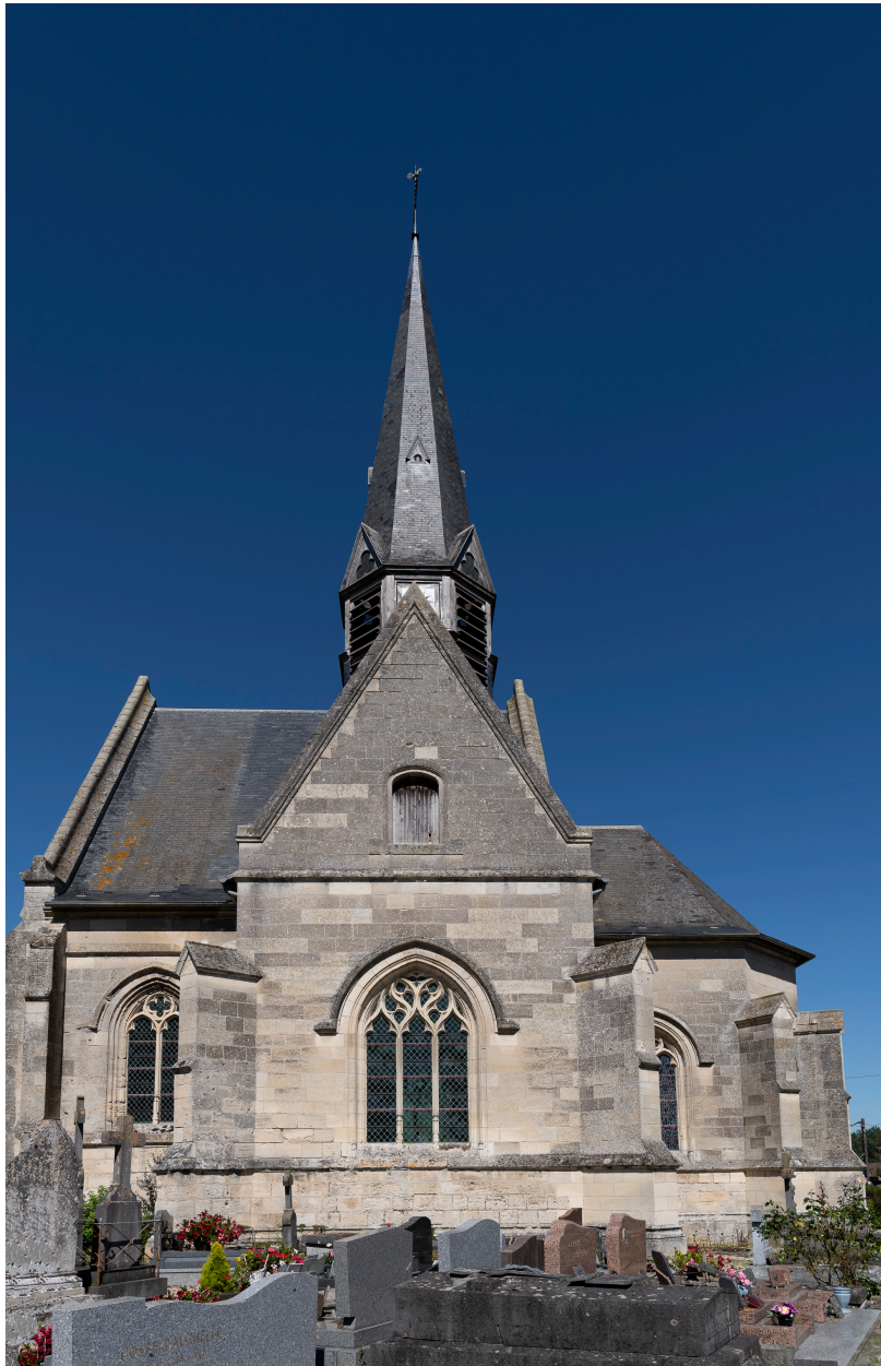
Élévation méridionale du chœur.
