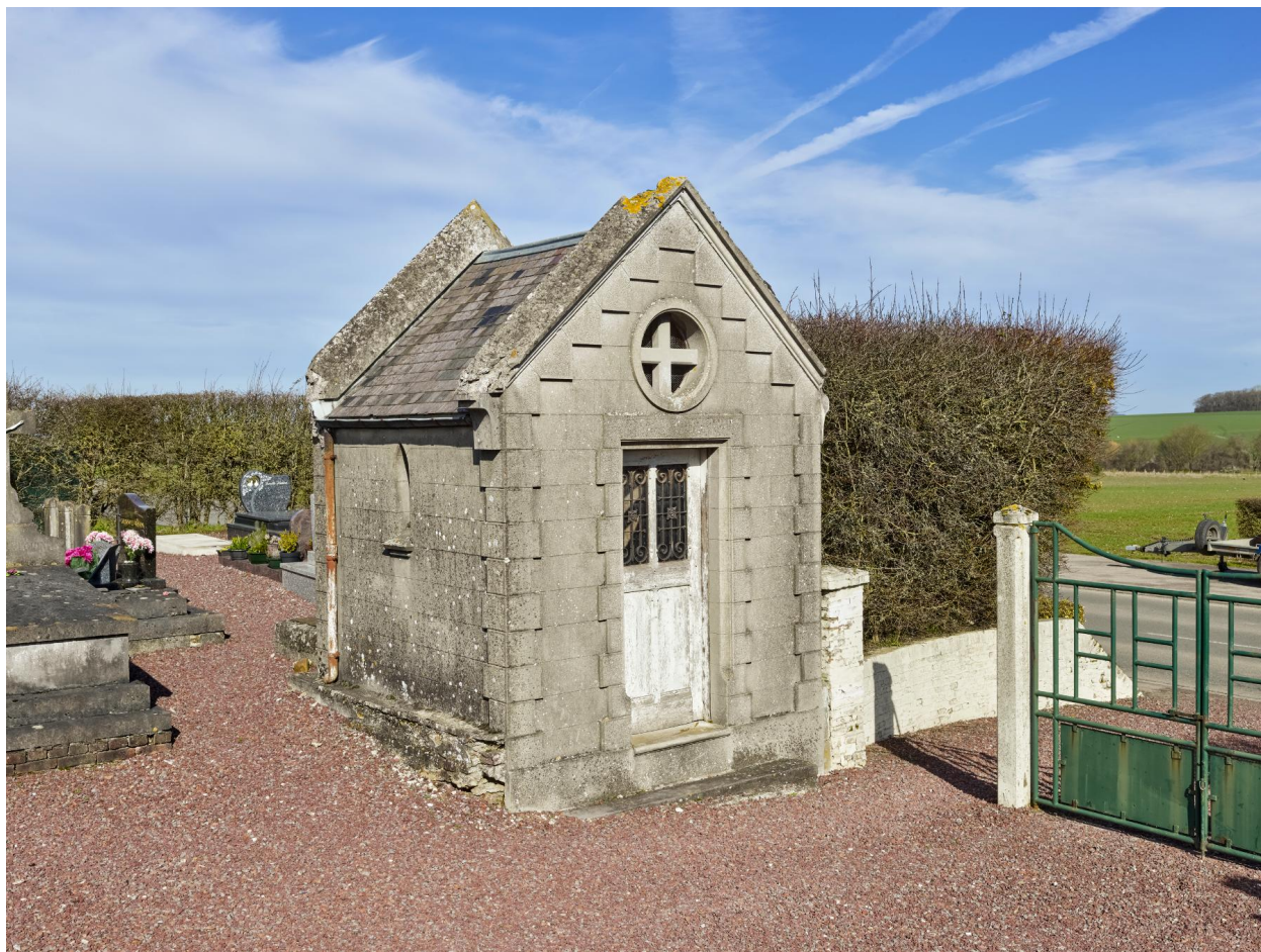
Chapelle à l'entrée du cimetière, depuis le sud-est.
