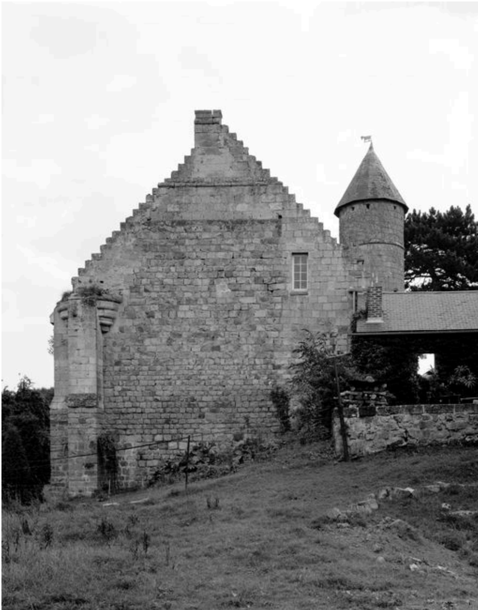
Logis. Pignon nord-ouest.
