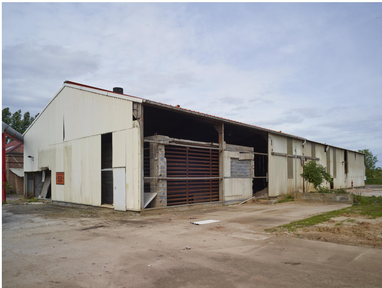
Hangar des séchoirs (étuves). Vue de trois quart prise vers l'ouest.
