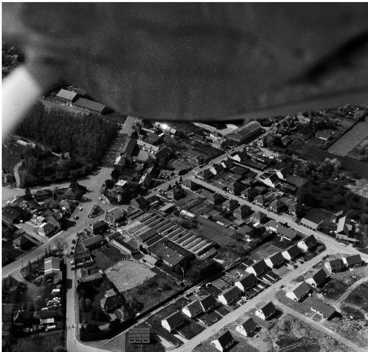
Vue aérienne, flanc est.
