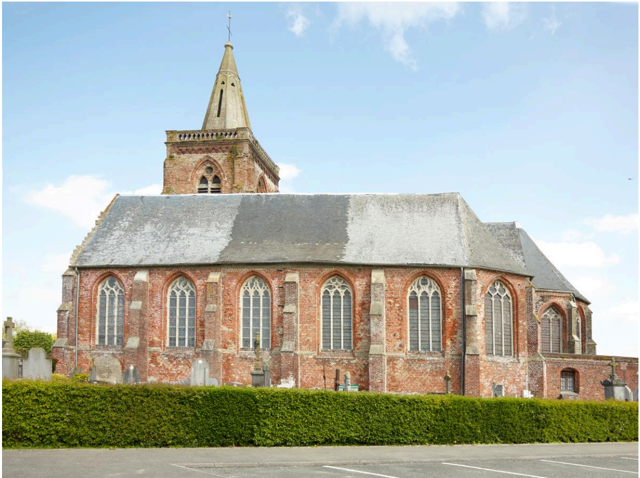
Vue générale depuis le sud.
