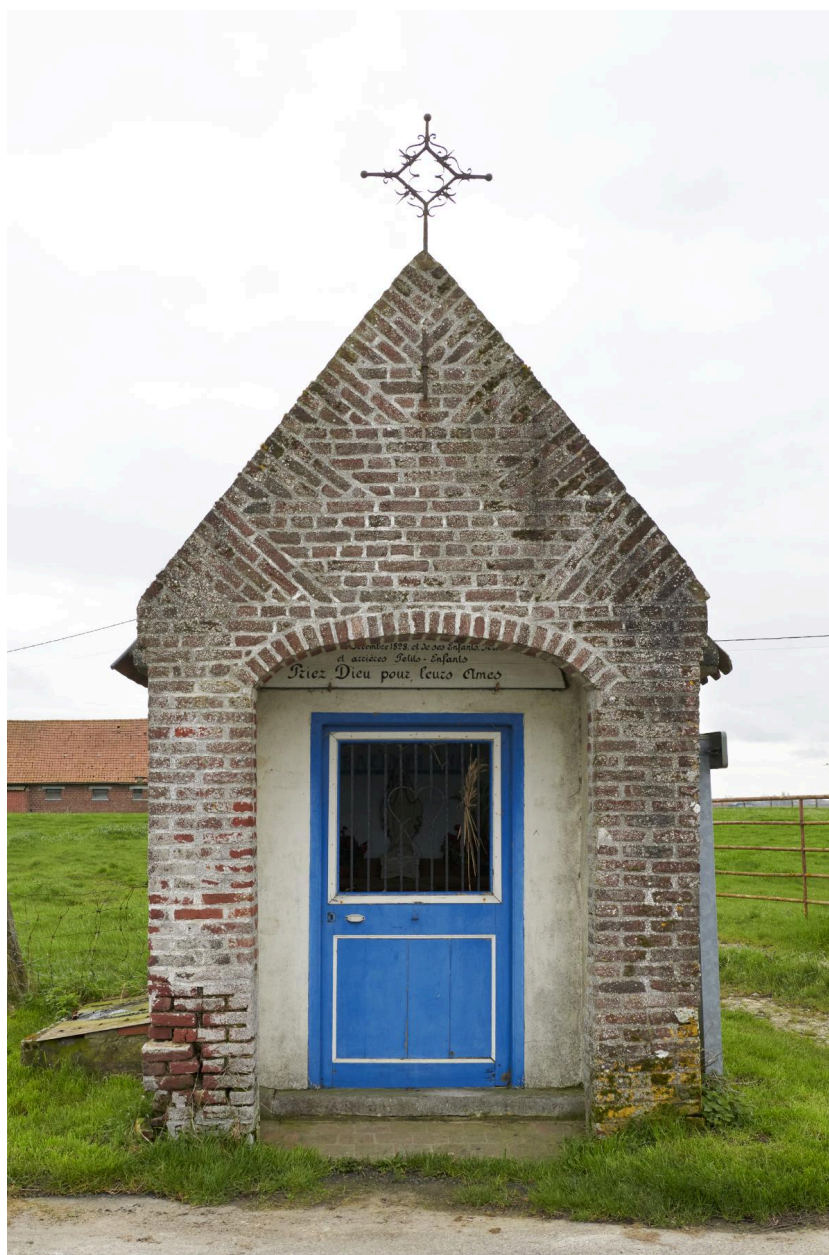
Vue de face de la chapelle.
