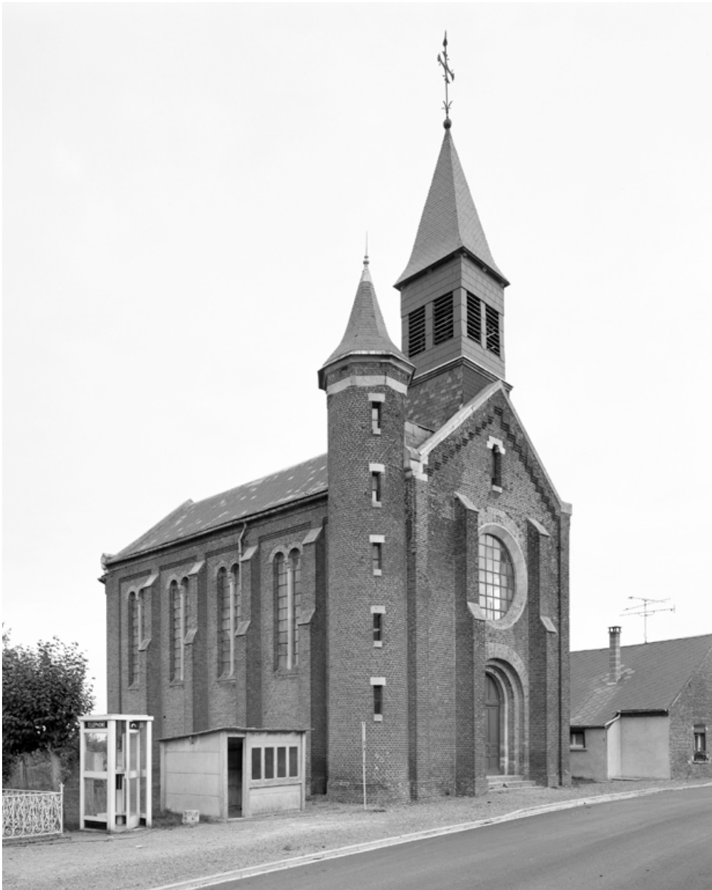
L'église vue du nord-ouest.
