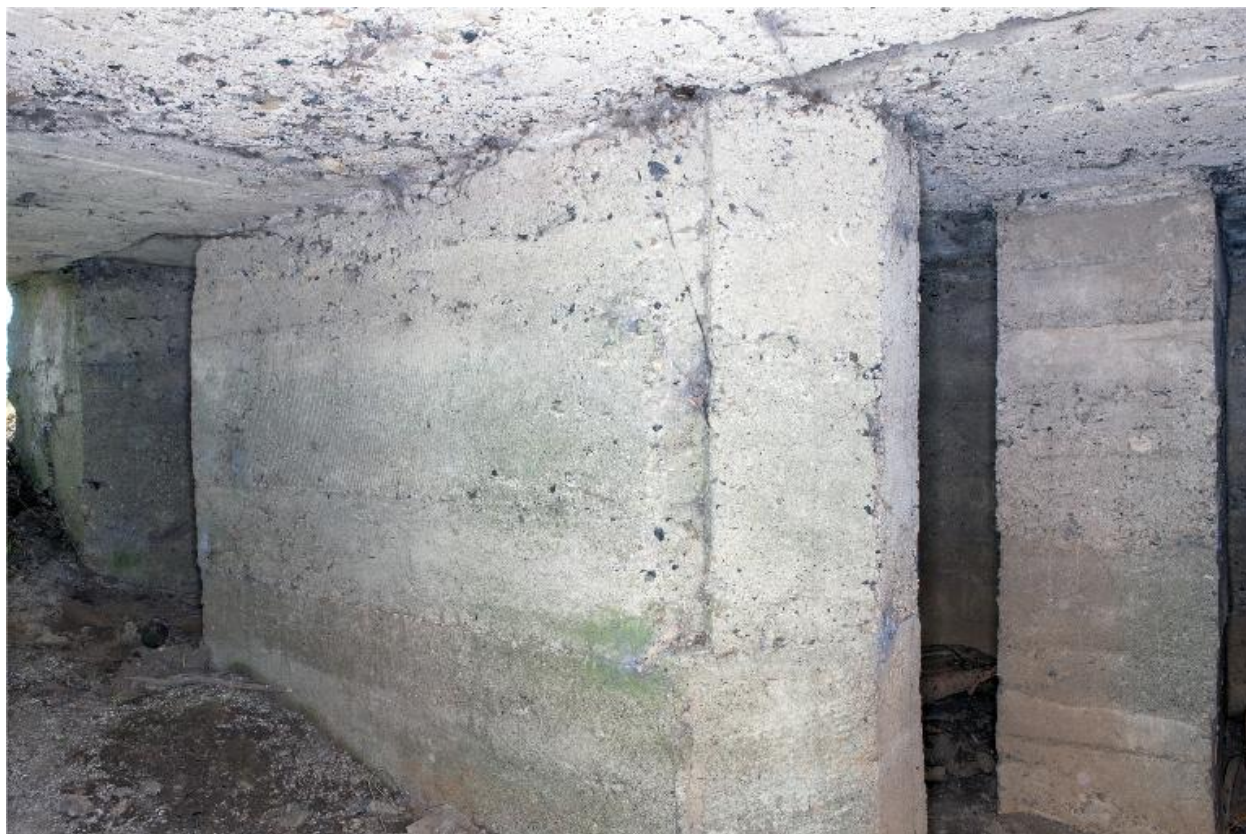
Couloir, vers l'entrée sud-est
