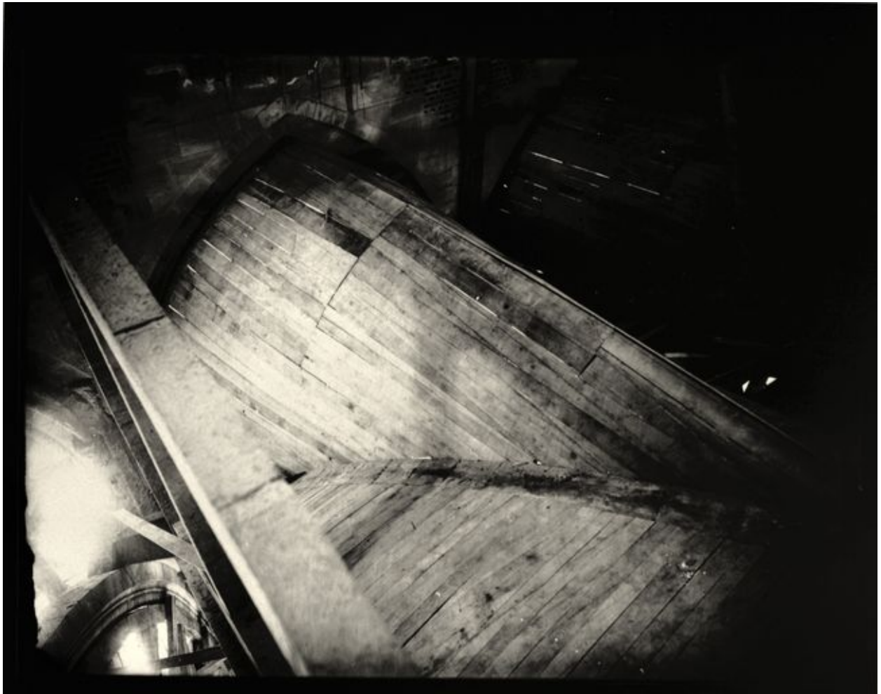
Détail de la réfection de voûtains du vaisseau central ou des transepts (photographie de l'entre-deux-guerres).
