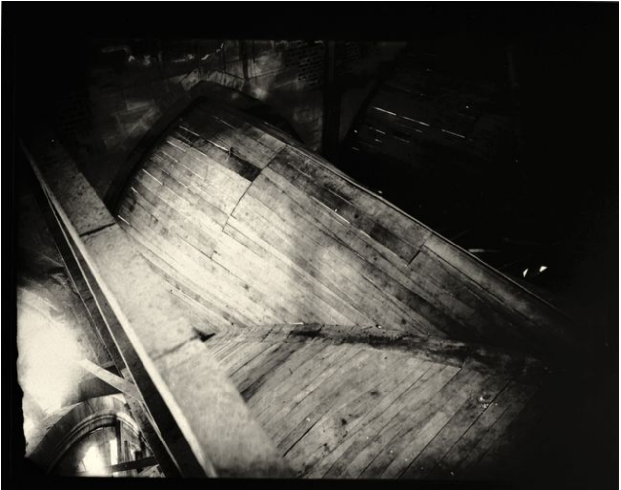
Détail de la réfection de voûtains du vaisseau central ou des transepts (photographie de l'entre-deux-guerres).
