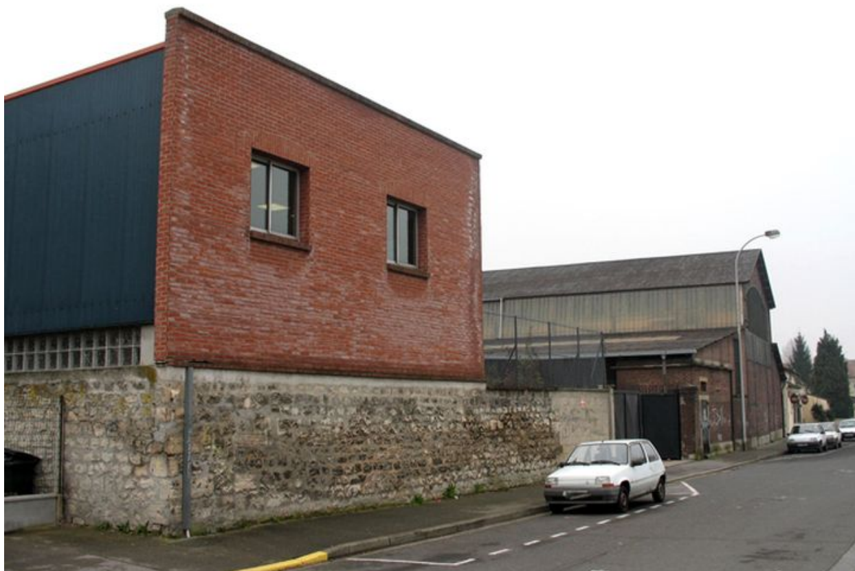
Emprise de l'usine sur la rue Michelet.
