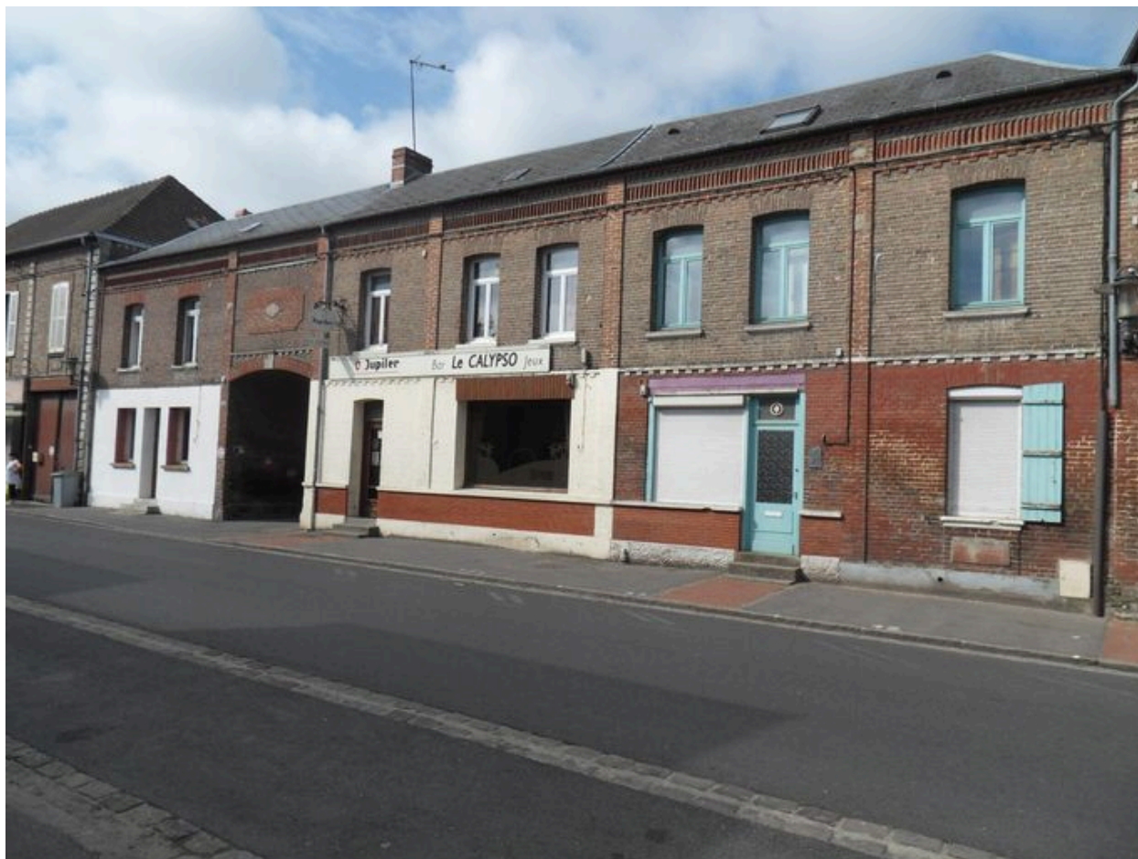
Maison à étage, 117 à 121 rue de la République (ancienne chaussée de Brunehaut).
