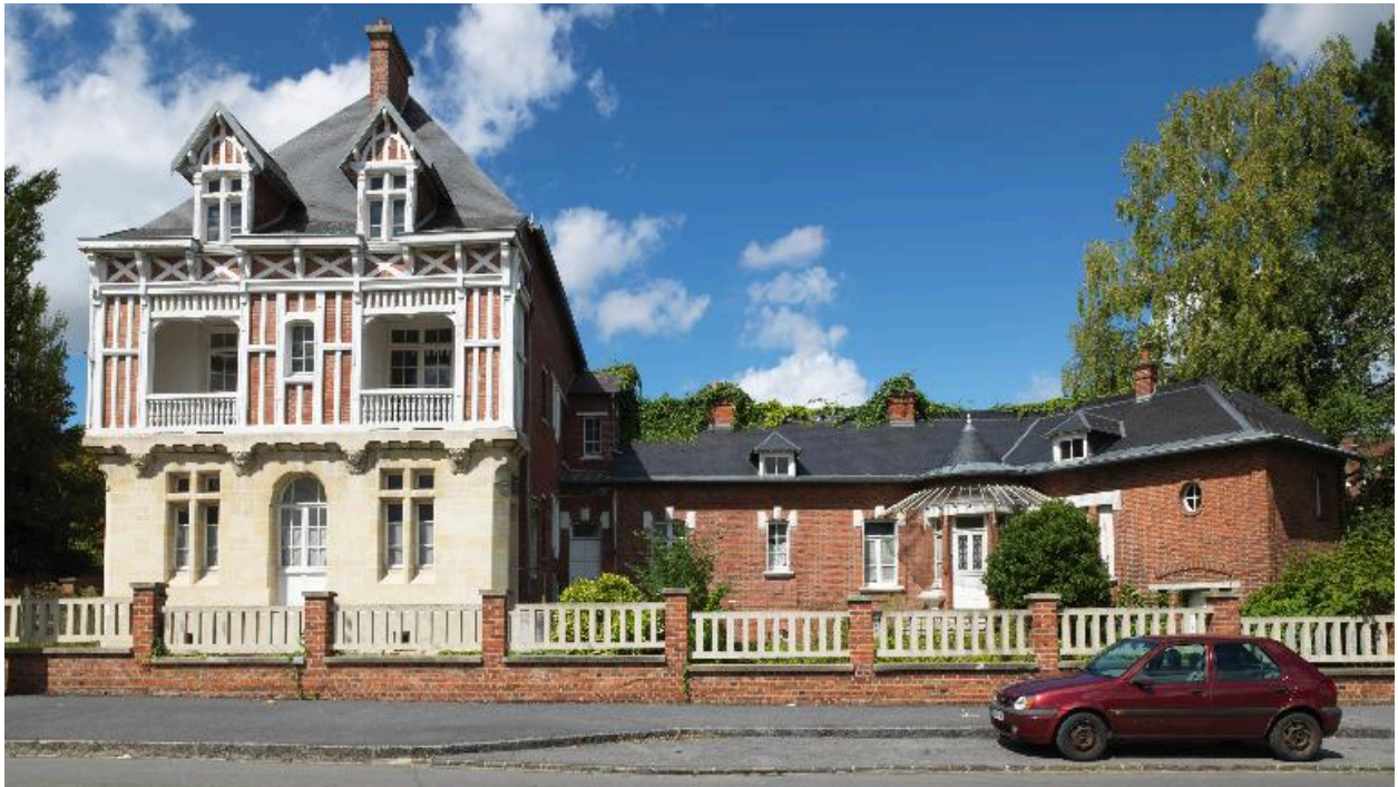
Vue depuis le boulevard du Poilu.
