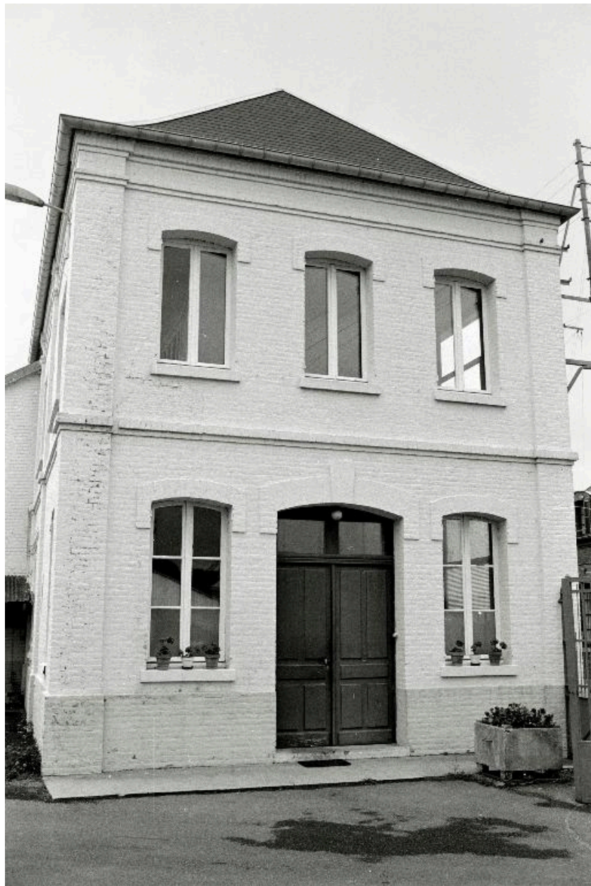
Elévation principale des bureaux, en 1990.
