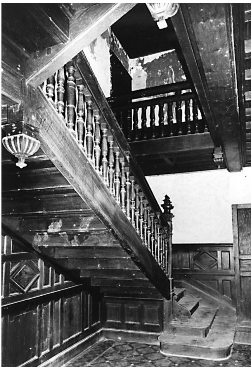
Escalier en retour avec jour (AP).
