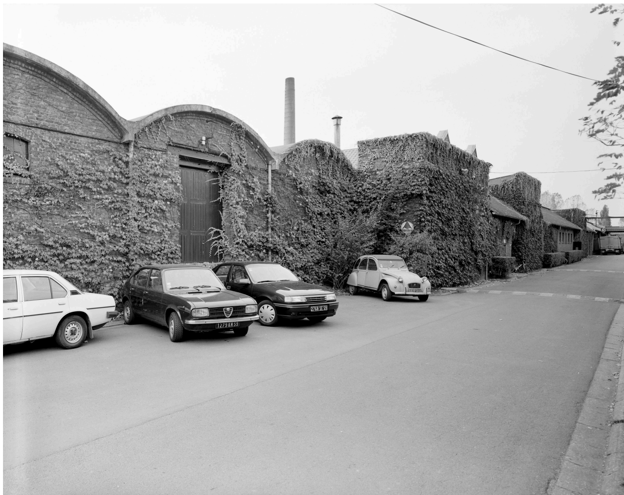
Atelier de fabrication, vue générale vers le nord.
