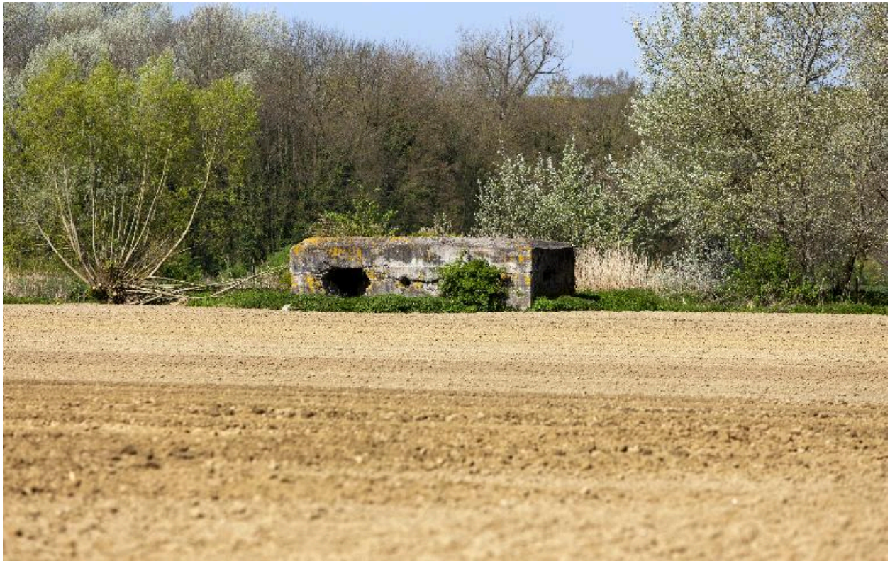
Vue générale vers le nord-ouest
