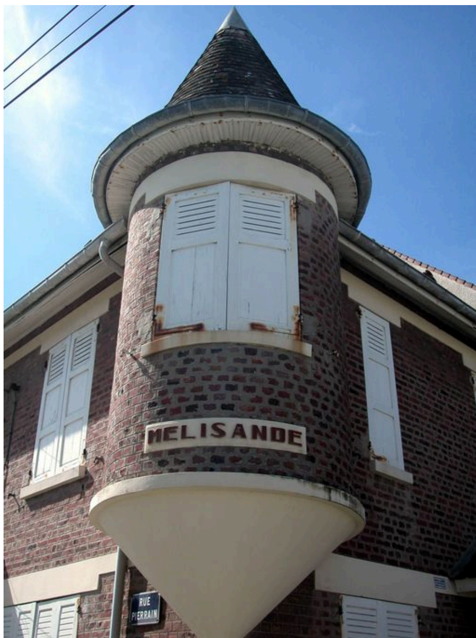
Détail de la tourelle d'angle en surplomb.
