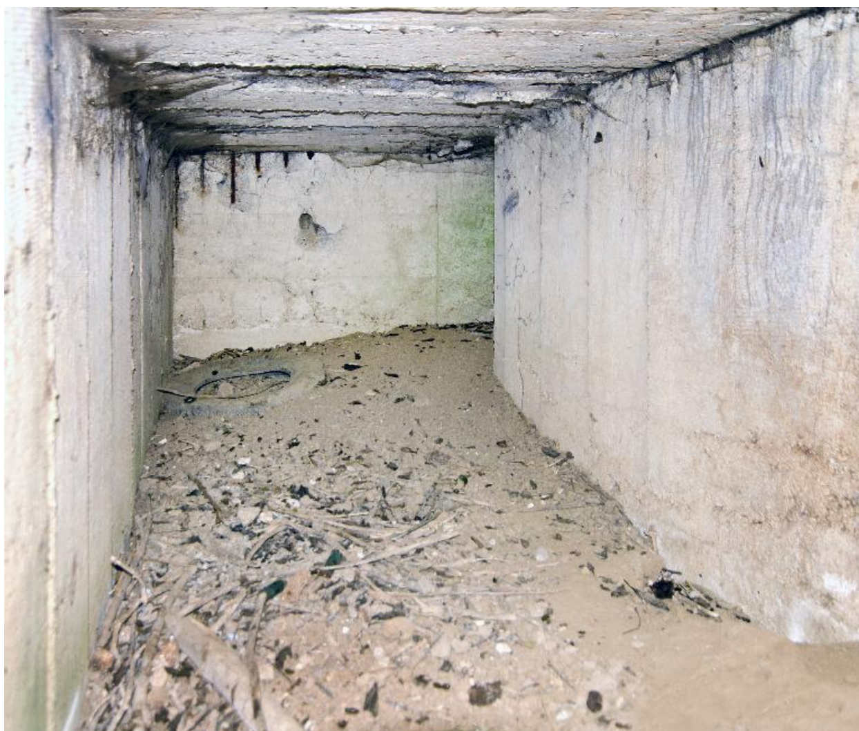
Couloir d'entrée sud, en grande partie comblée
