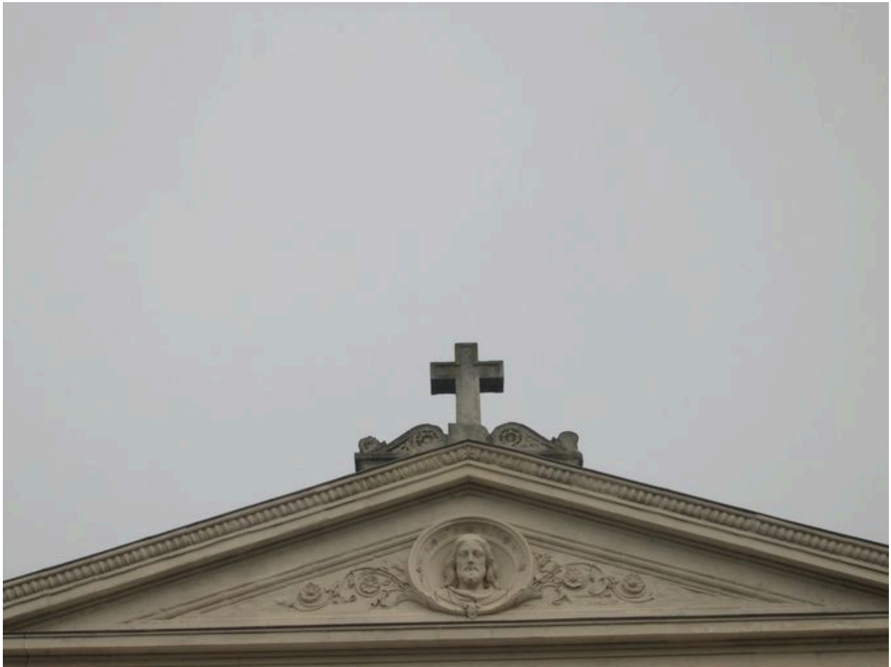
Vue de détail : fronton du couronnement.
