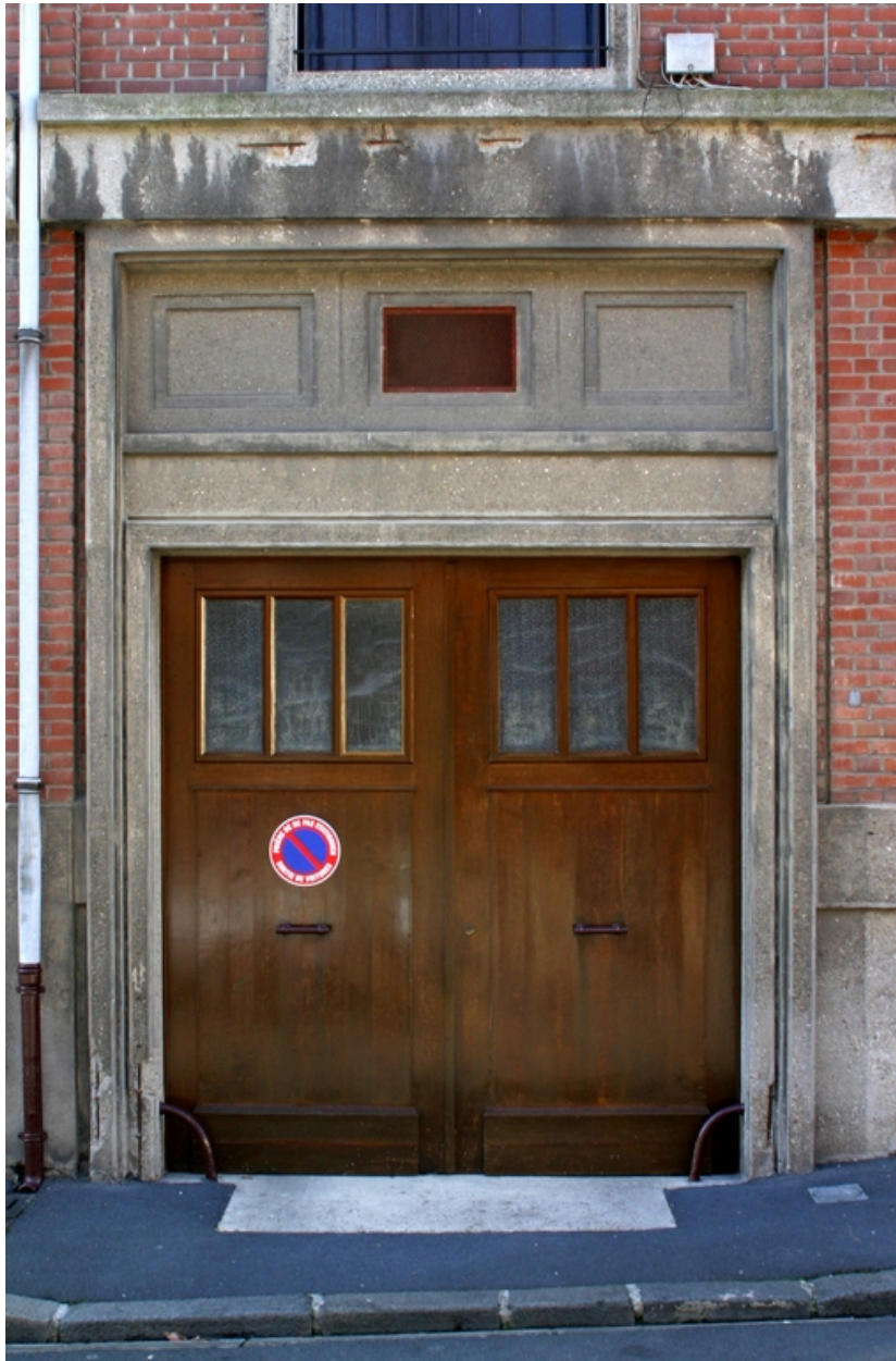
Porte cochère de l'immeuble d'habitation, rue de Colmar.
