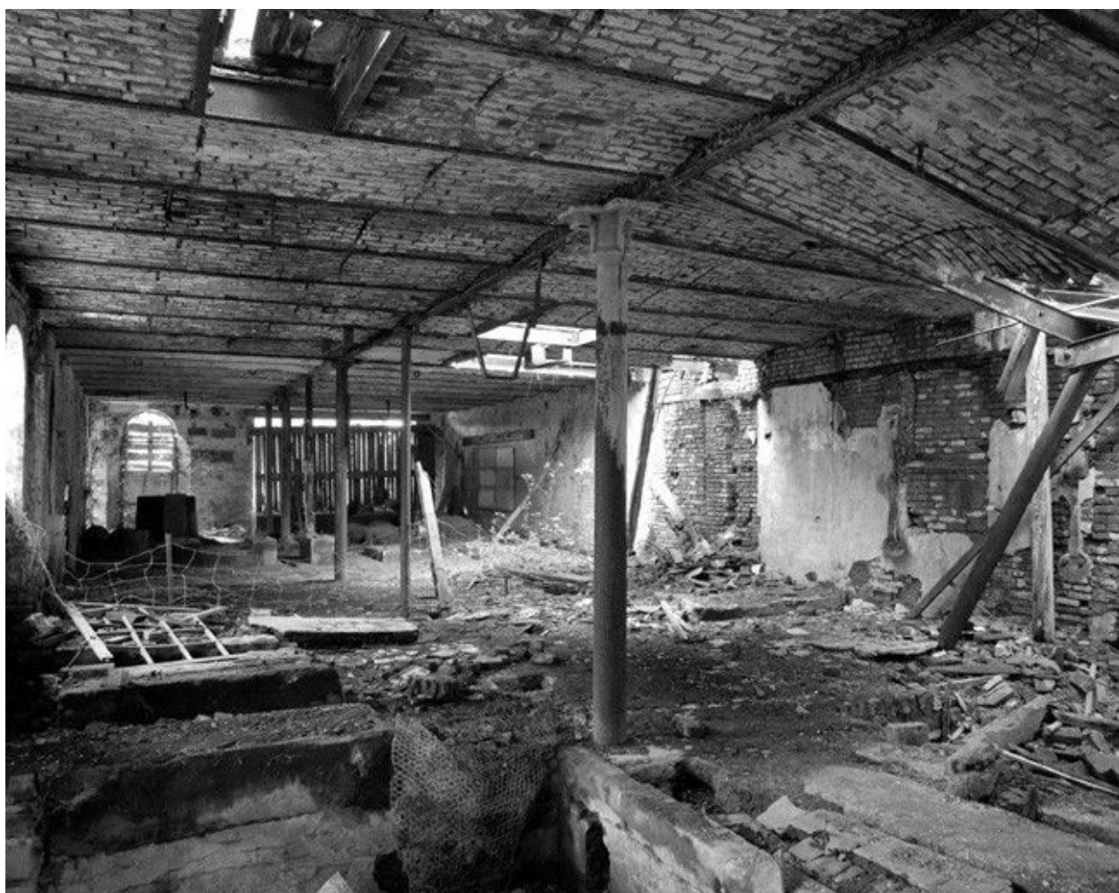
Vue intérieure de l'atelier (salle des piles ou salle de transmissions).
