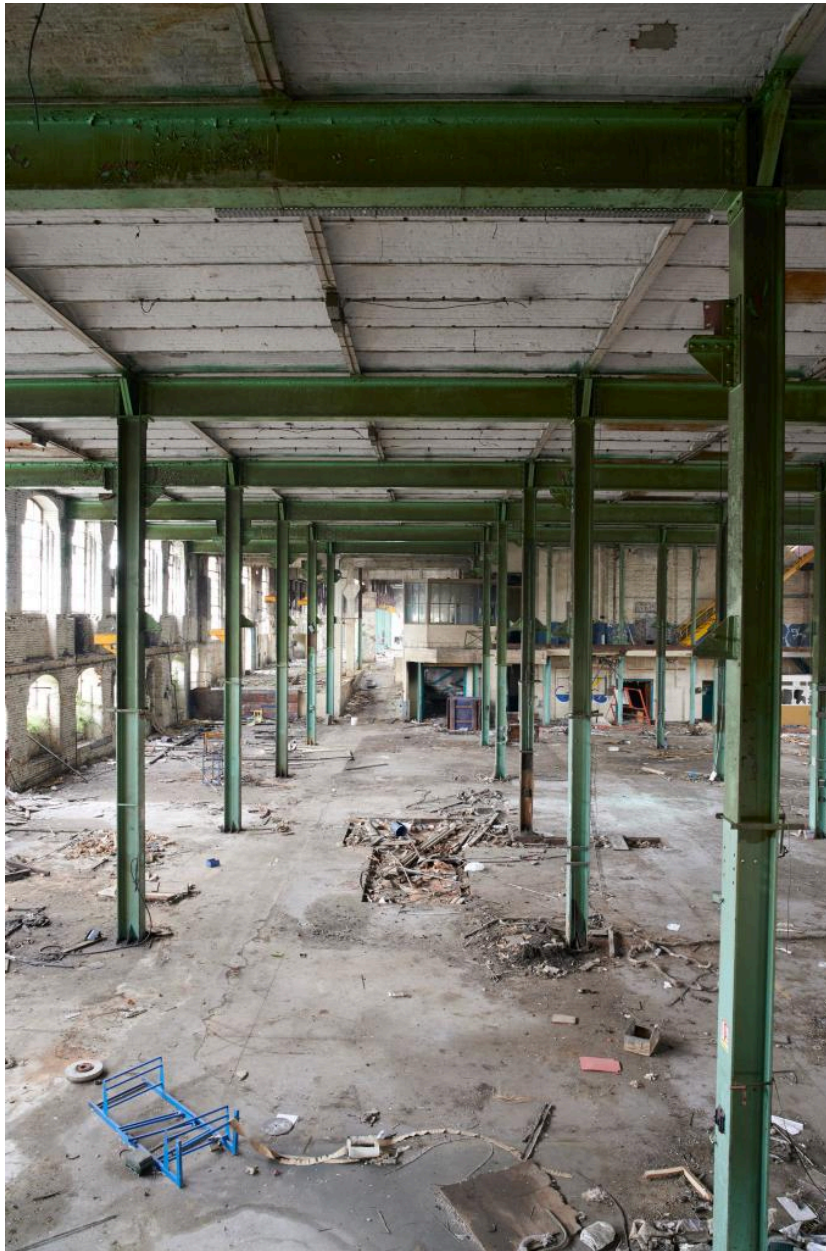
Vue intérieure de la filature (le plancher du rez-de-chaussée surélevé a été supprimé).
