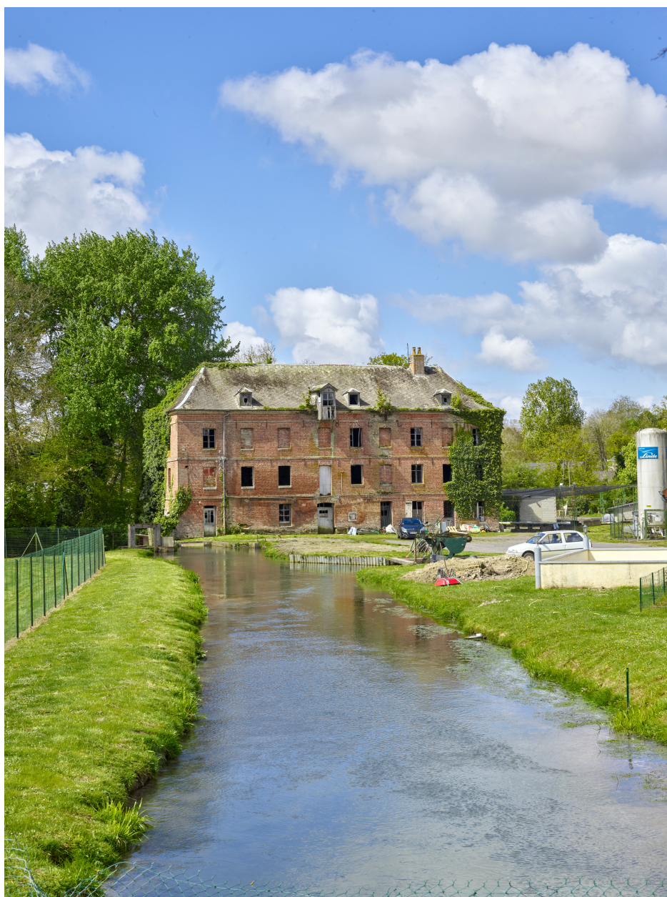
Vue du moulin et du Scardon, depuis l'est.
