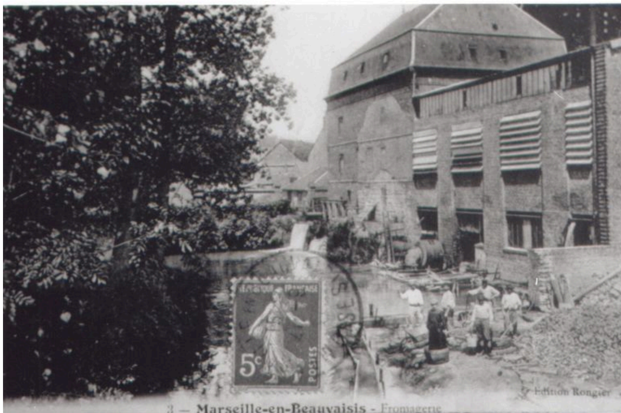
La fromagerie avec le haloir en cours de construction, vers 1908. (carte postale, collection particulière).
