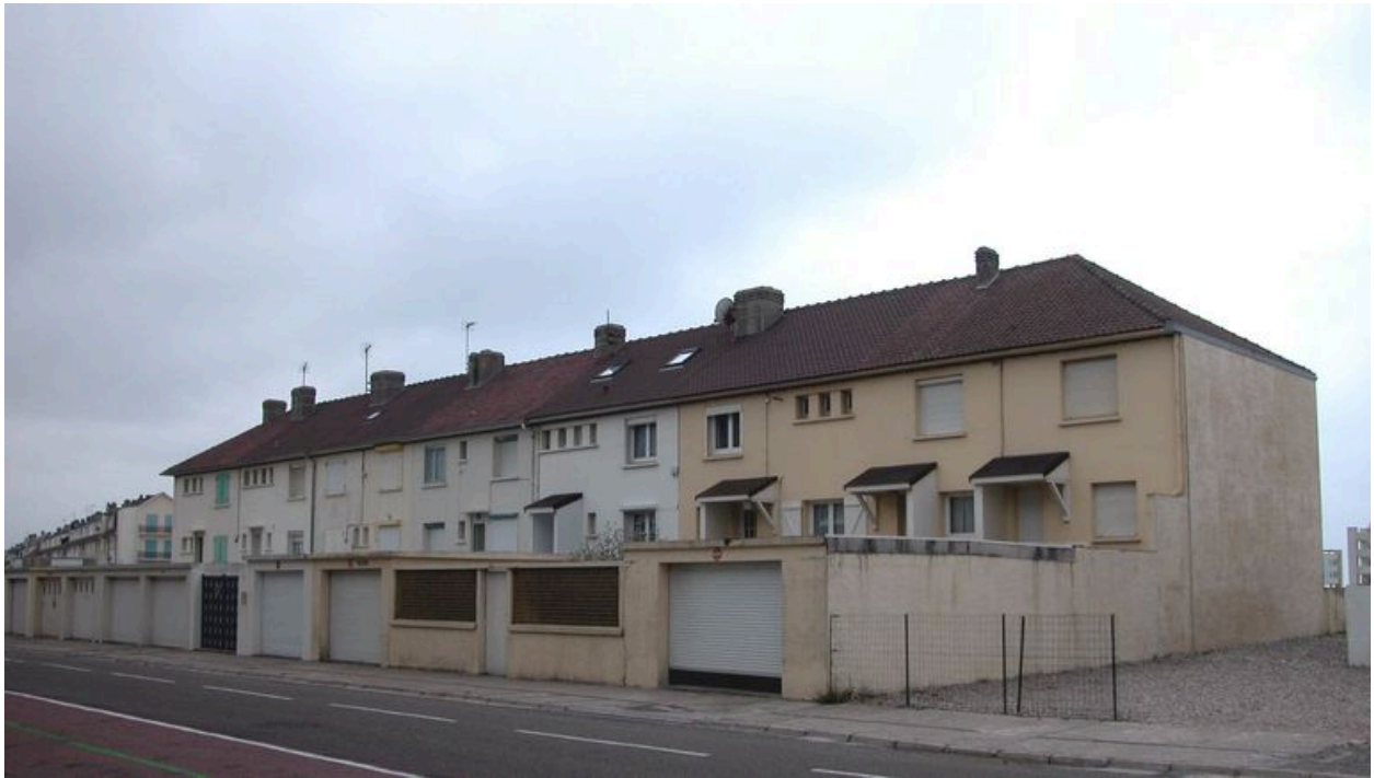
Vue d'ensemble des façades postérieures.
