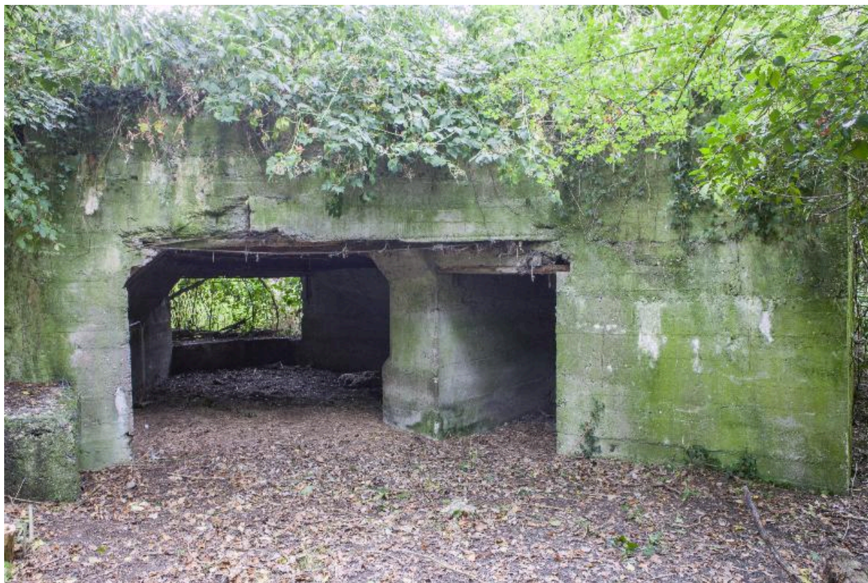
Entrée de la chambre de tir et celle de la soute à munition
