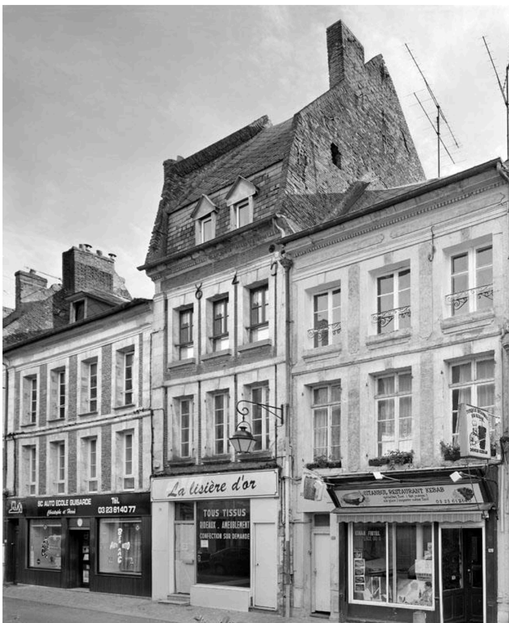
Vue de la façade sur rue.
