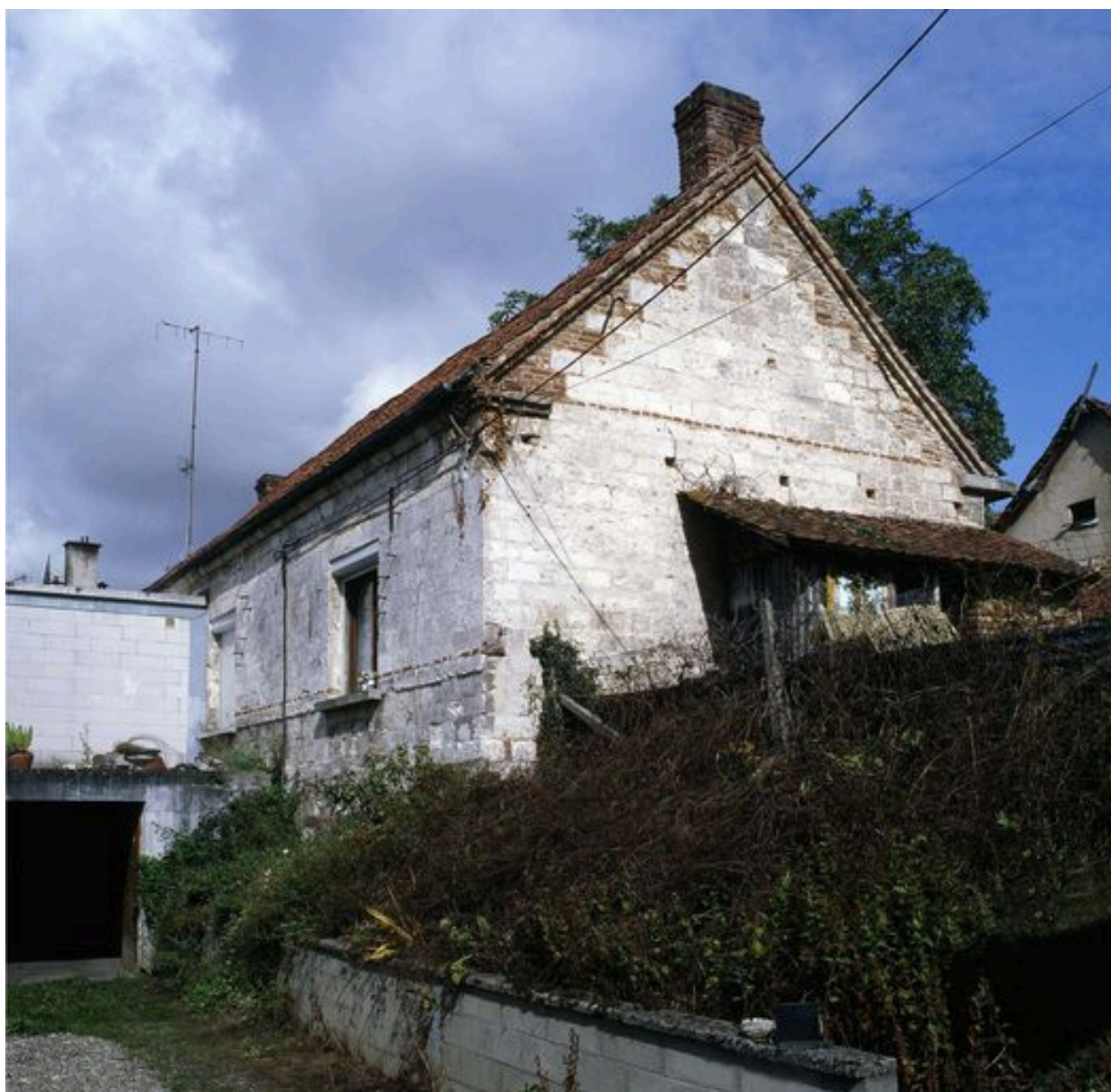
Vue du pignon extérieur du logis.
