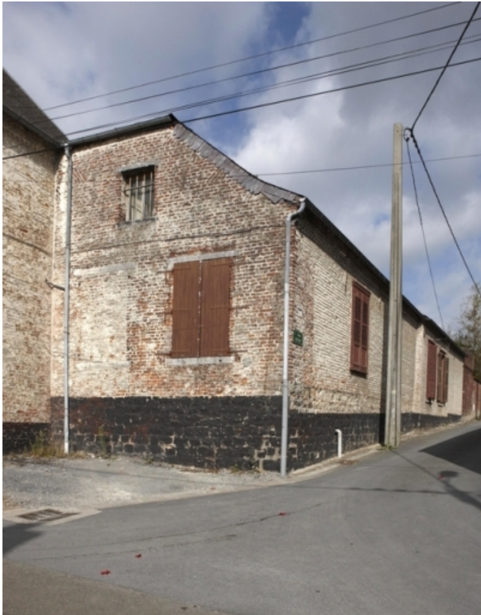
Vue de l'élévation sur rue du bâtiment abritant les pièces de réception.
