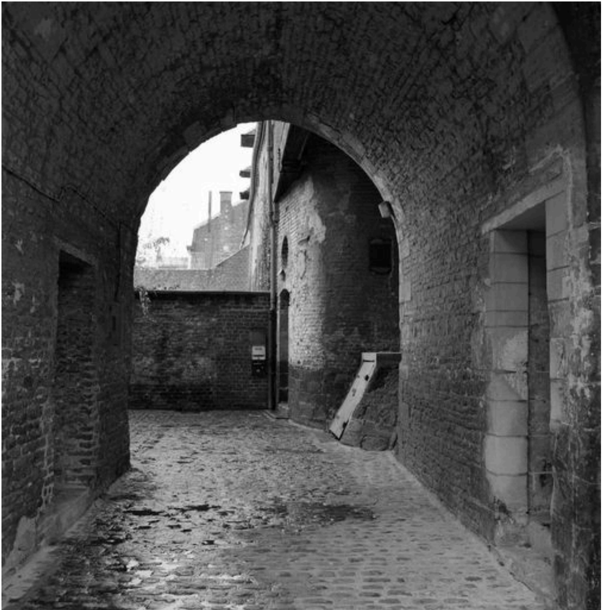
Corps de logis médiéval, passage couvert, vue depuis la façade vers l'arrière.
