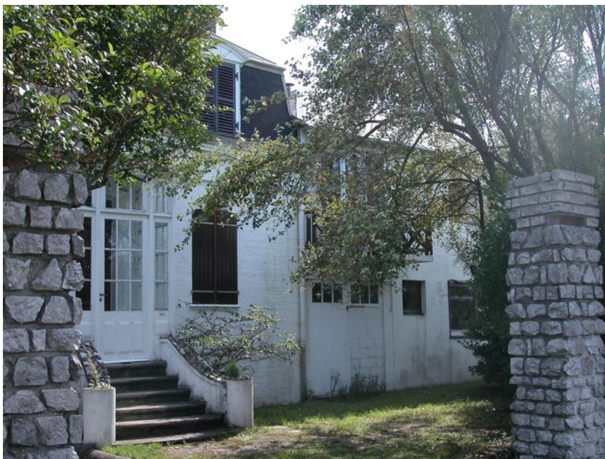
Détail de l'extension latérale.
