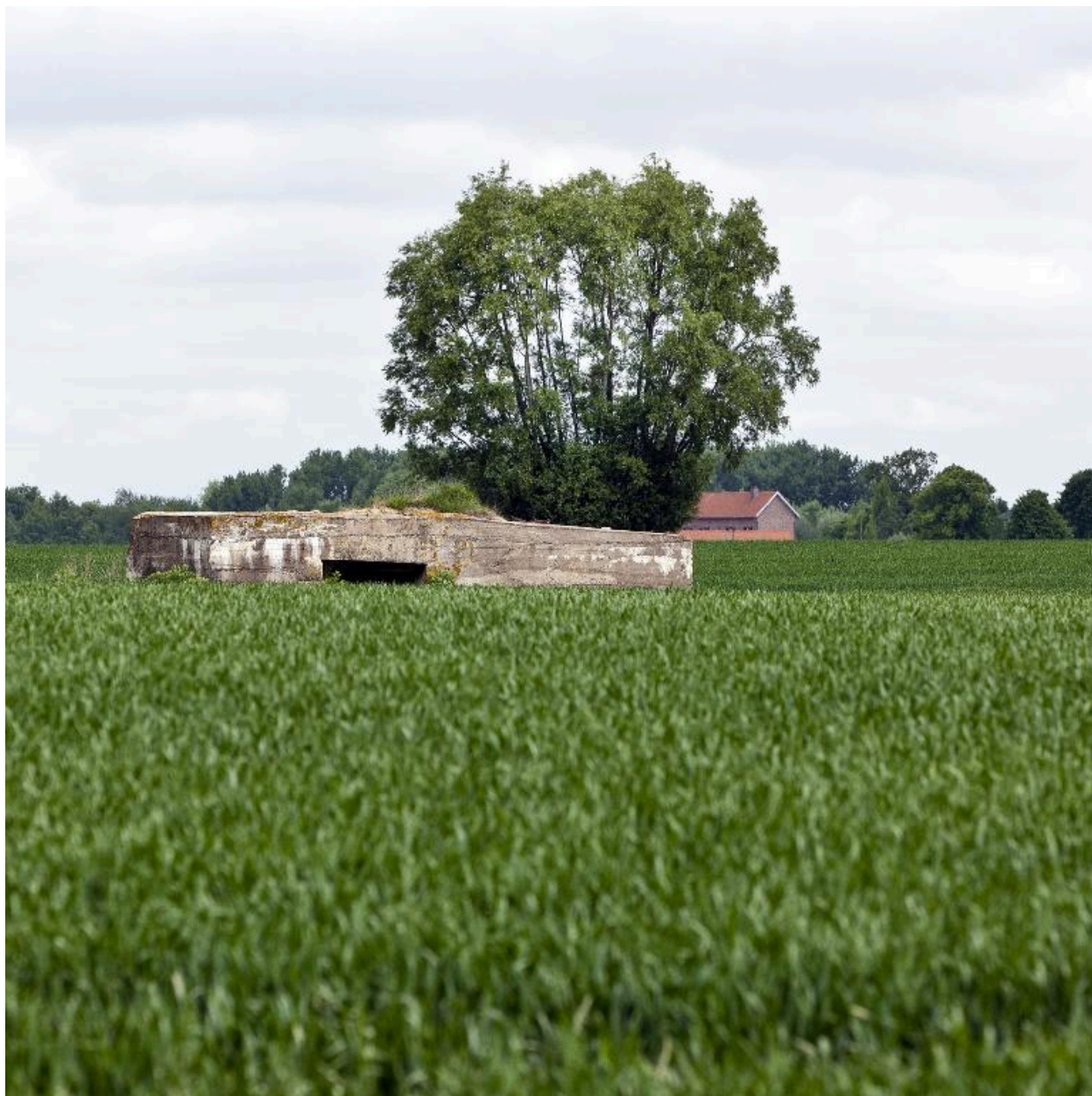
Elévation antérieure, vers le nord-ouest
