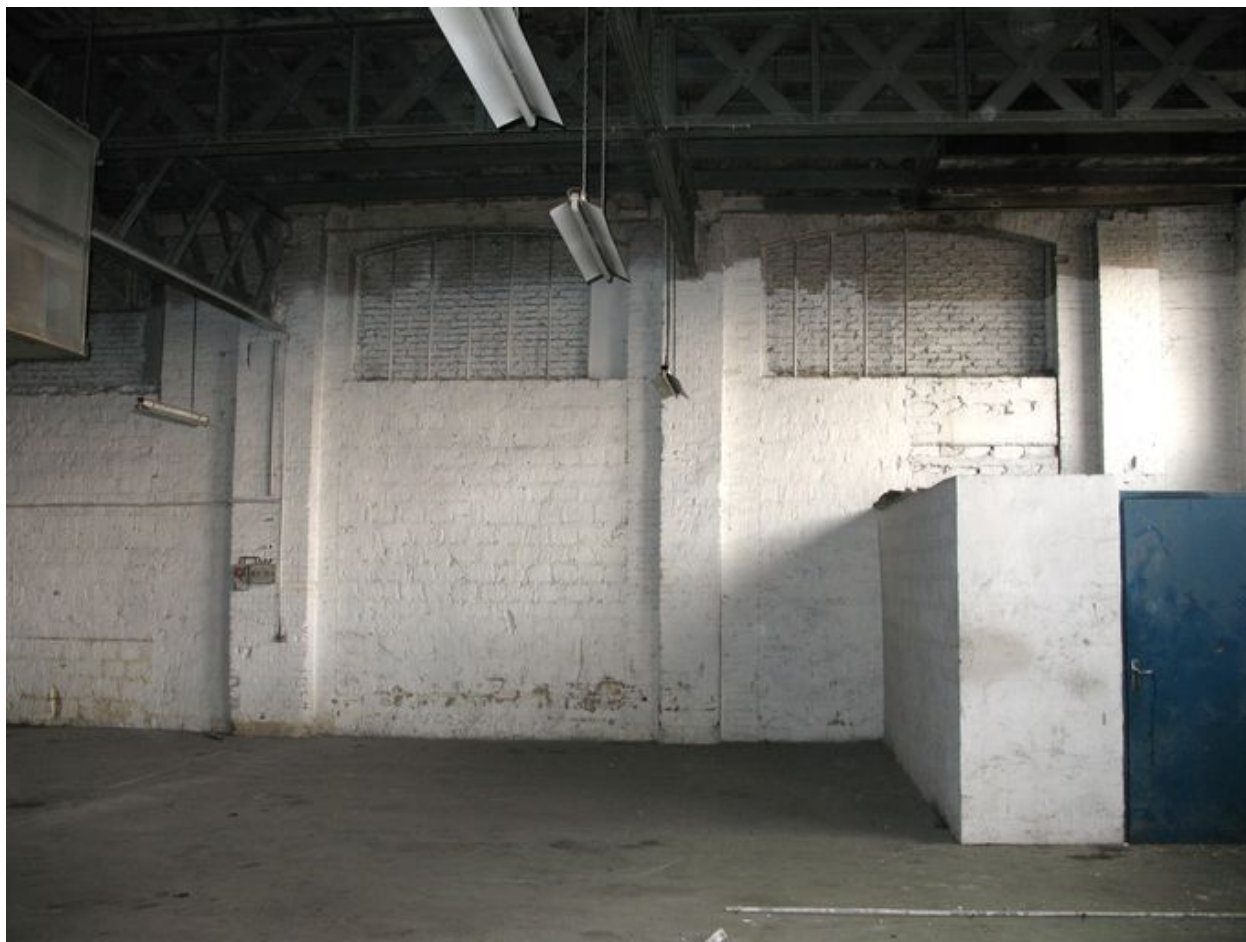
Trois travées du mur ouest de l'usine au rez-de-chaussée.
