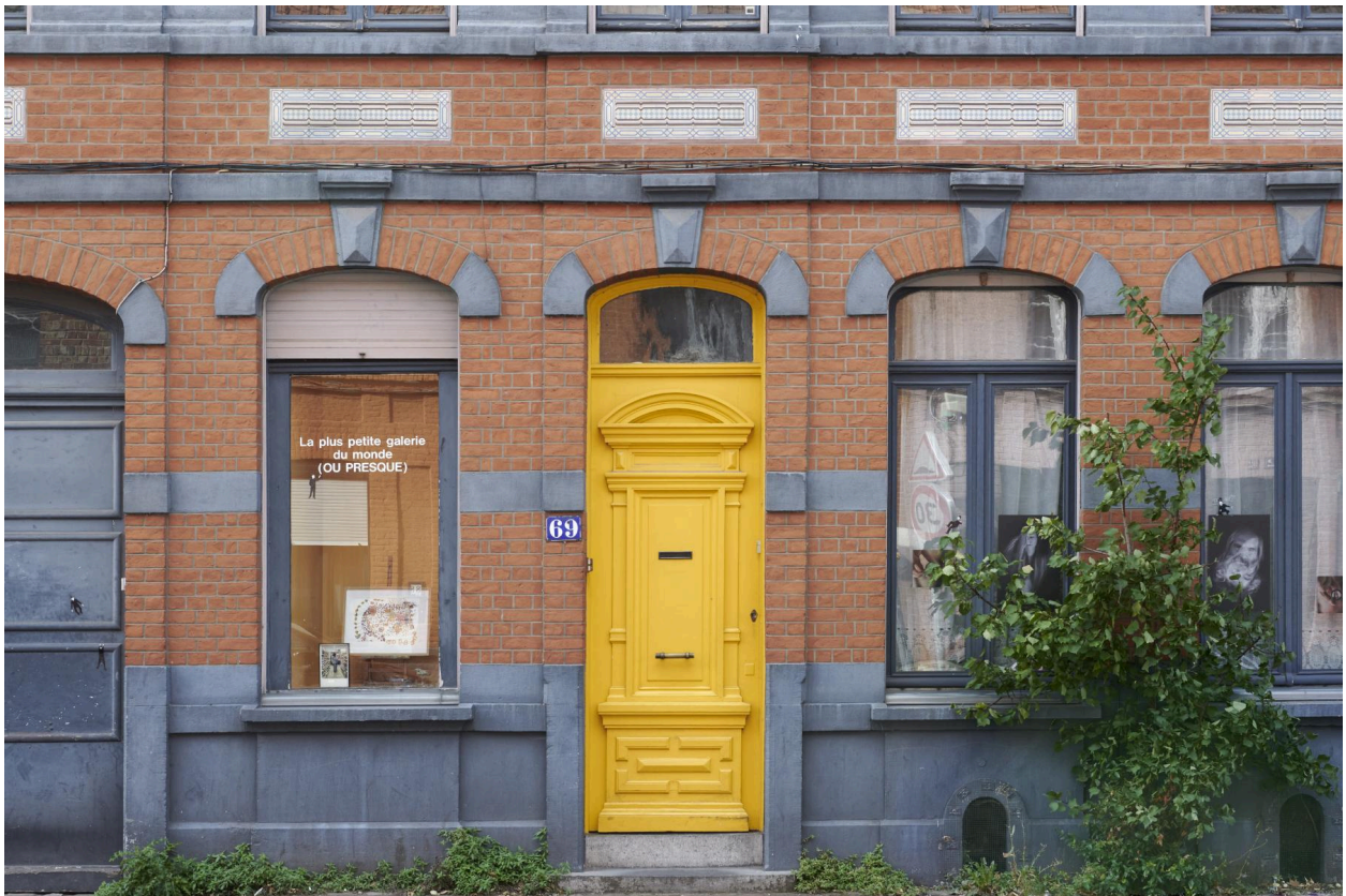
Détail de la porte et des mosaïques.
