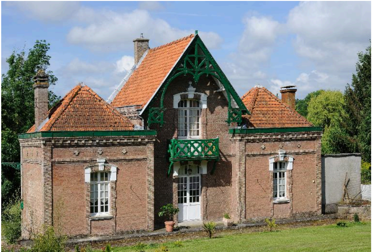
Façade sur rue, vue de trois-quarts.
