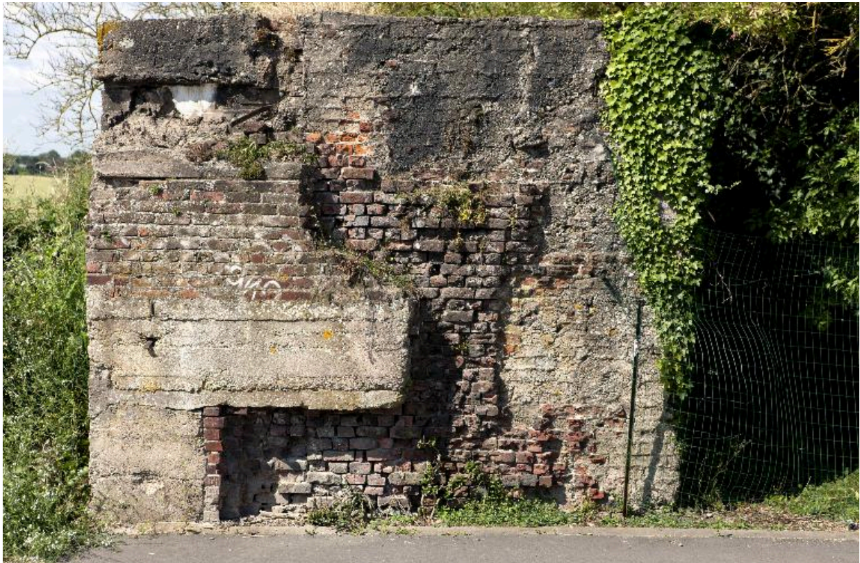
Elévation sur la rue de Sequedin
