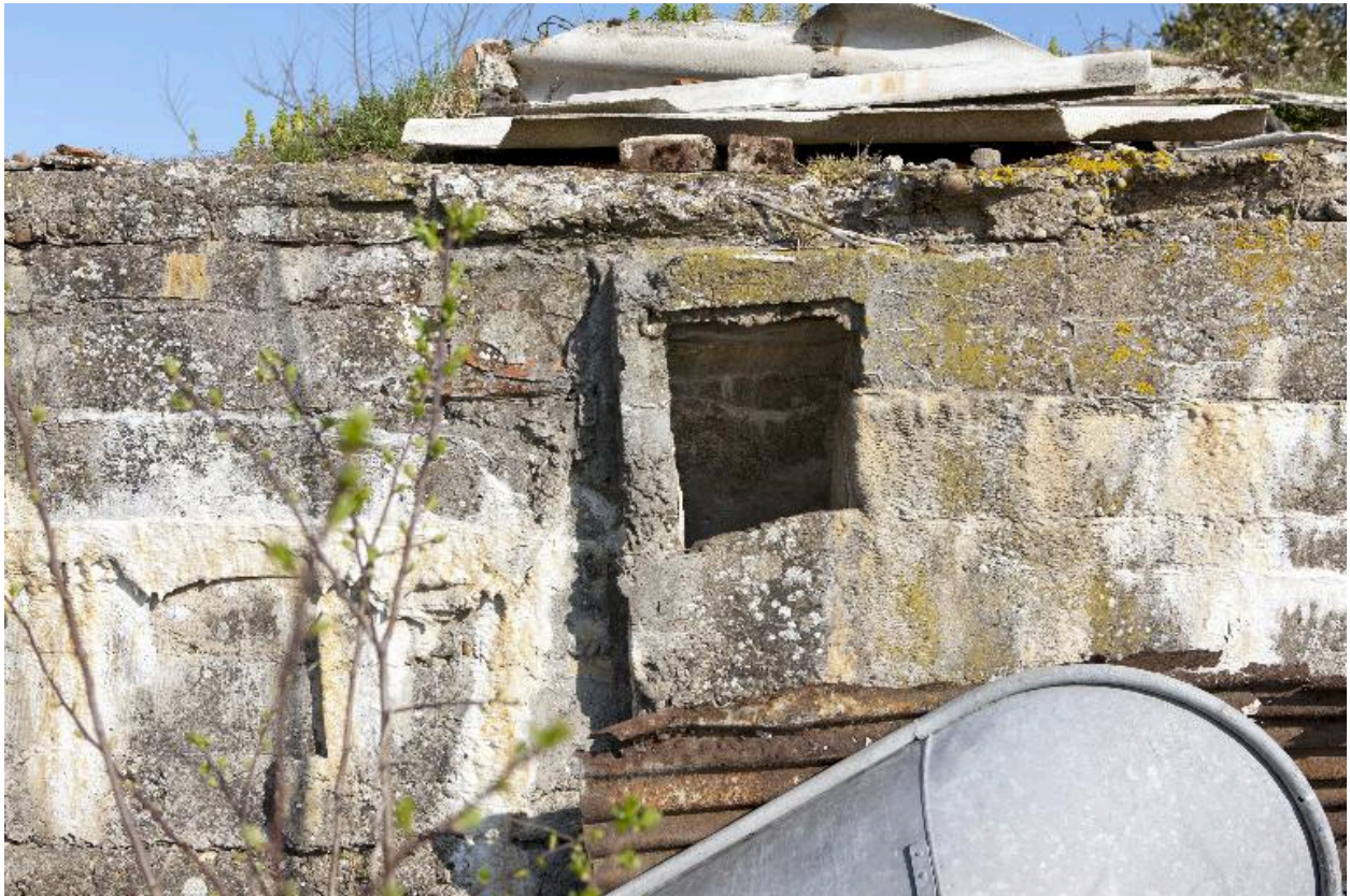
Casemate A. Ouverture sur l'élévation sud
